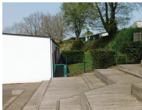
Accès 5, utilisé pour l'entretien de l'espace vert, non accessible par les élèves.
