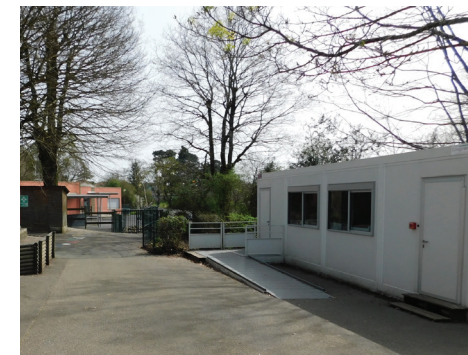
A droite, le module préfabriqué et sa rampe métallique.
