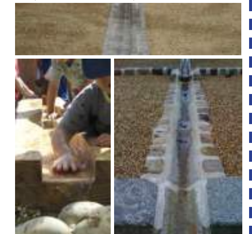
La RIVIÈRE D'EAU saisonnière raccordée sur la récupération des eaux de pluies
